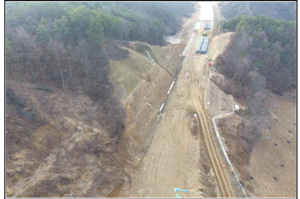
【그림 4】 깎기비탈면 종점부 측면 사진
