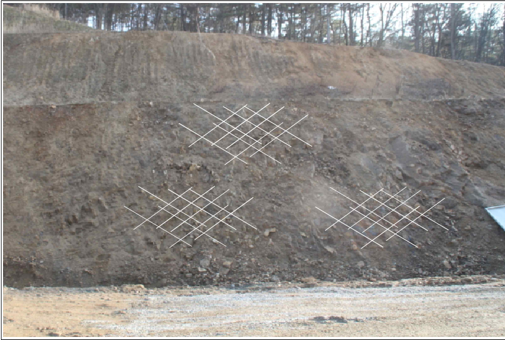
【그림 17】 B 영역 상세사진 (세편화된 암석)
