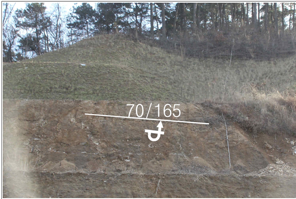
【그림 12】 A 영역에 발달한 불연속면
