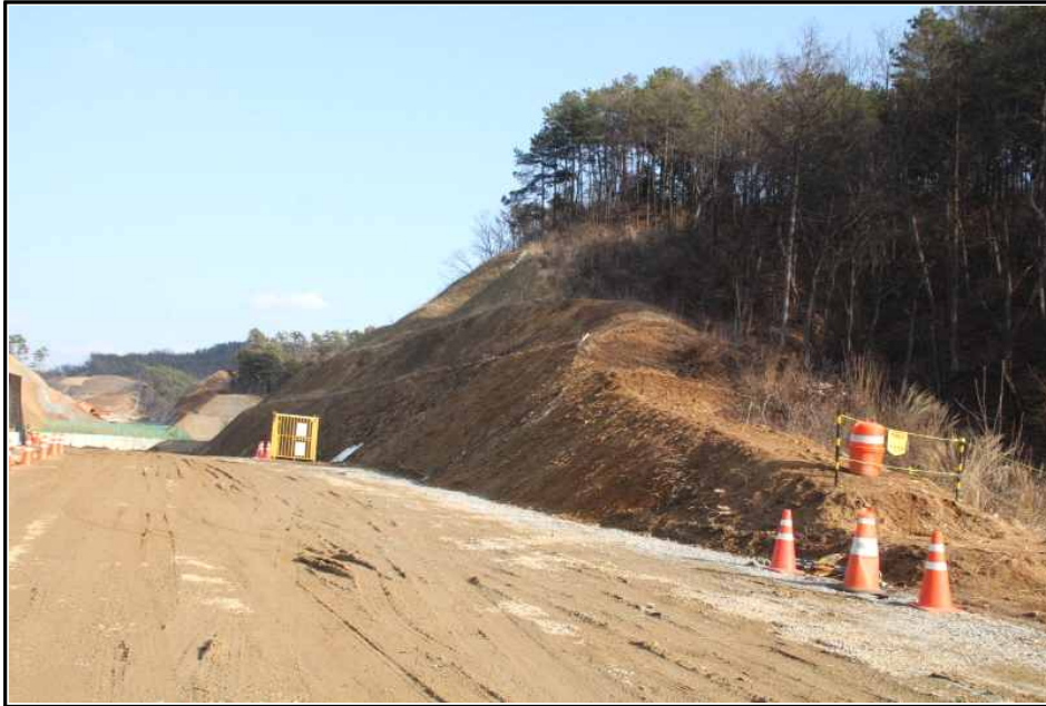
【그림 3】 깎기비탈면 시점부 측면 사진
