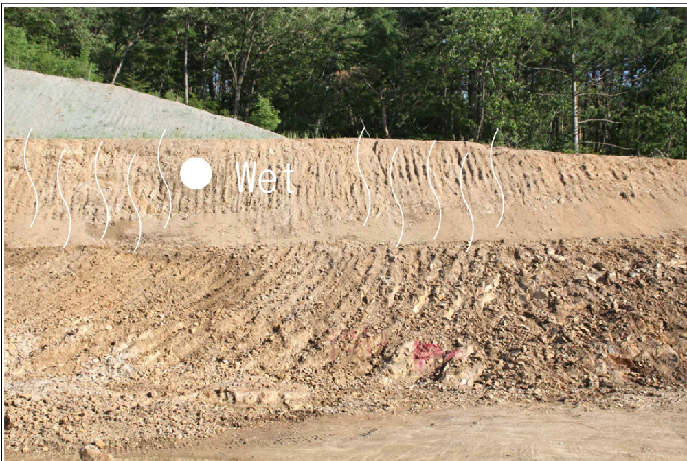
【그림 18】 B 영역 상세사진 (토사유실 및 우류침식, 지하수 유출)
