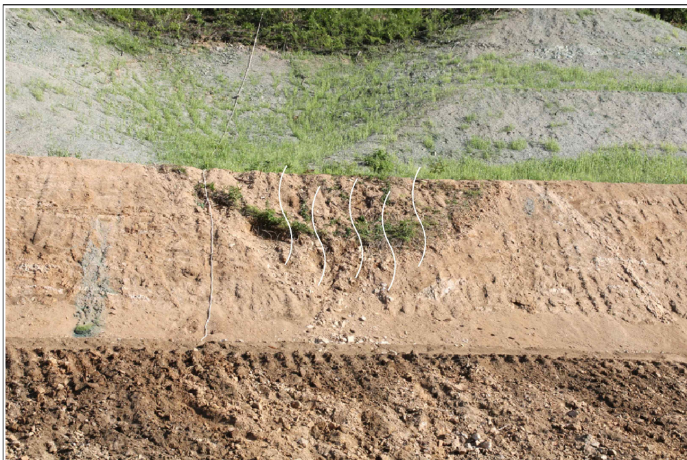
【그림 15】 A 영역 상세사진 (토사유실 및 우류침식)
